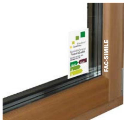
Le finestre, dal punto di vista dell'isolamento termico sono un dei punti di più deboli dell'intero involucro edilizio; possono dissipare fino al 40% di tutta l'energia necessaria per il riscaldamento e raffreddamento dell'intero involucro edilizio a causa della trasmissione diretta, delle perdite dovute agli spifferi e in seguito ad una areazione non corretta.
